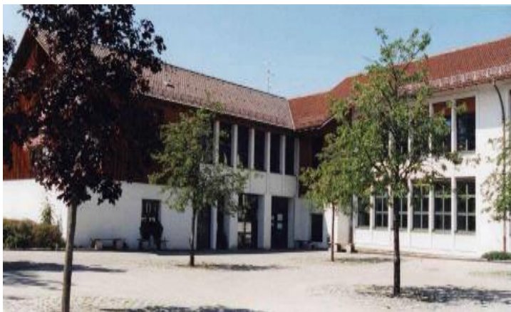
Staatliche Realschule Wolfratshausen
